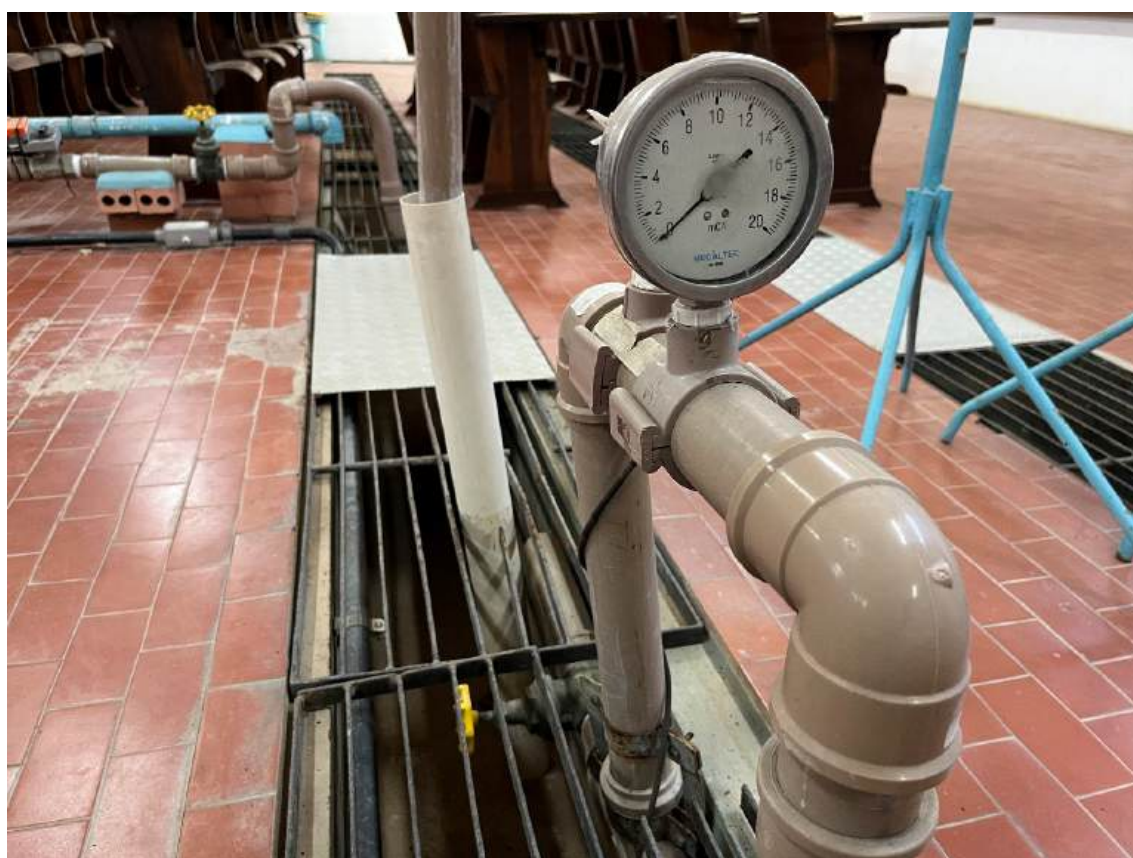
Figura 5.7 – Manômetro instalado em um dos trechos do SPDA.
