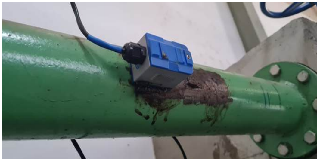
Figura 16 – Transdutor ultrassônico de medição de vazão.
