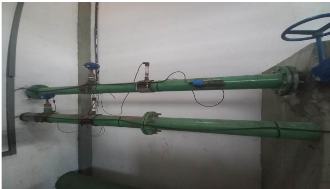
Figura 15 – Localização dos sensores na casa de bombas.
