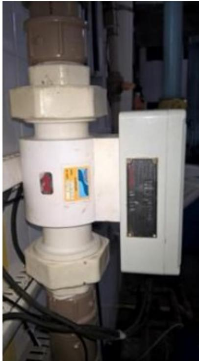
Figura 16. Transdutor de Vazão
