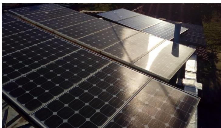
Figura 58. Sistema fotovoltaico contendo 14 módulos, m-Si Isofoton IS-70/12 de 70 Wp montados no CEAR/UFPB, João Pessoa - PB. Fonte: Guillermo Andrés Rodríguez Cantor. Acervo pessoal.
