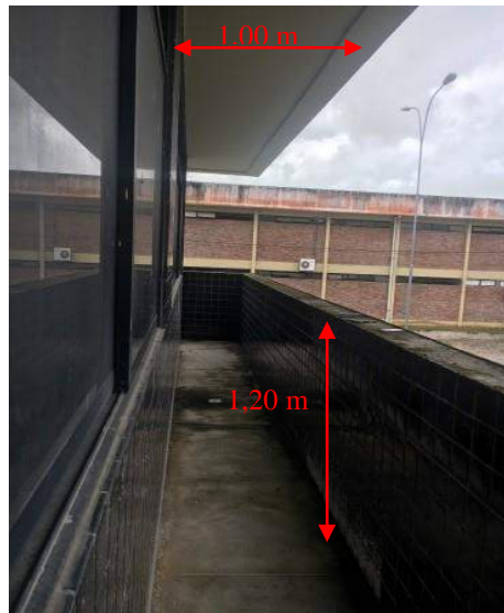
9b - Varanda técnica com acabamento em cerâmica 10cm x 10cm na cor preta, teto em forro de gesso com pintura branca acrílica fosca e esquadrias das salas com perfil em alumínio, pintura preta e vidro fumê
