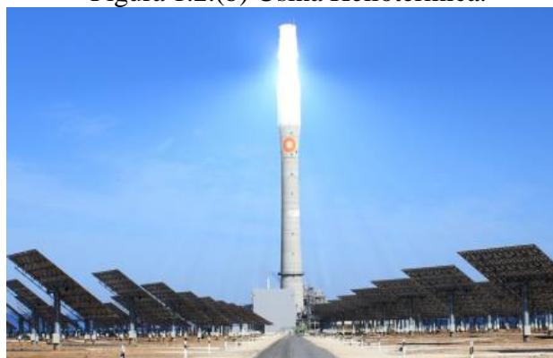
Figura 1.2.(b) Usina Heliotérmica.
