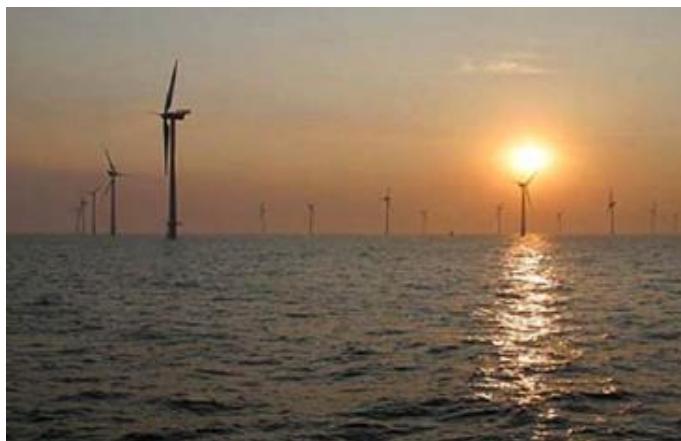
Figura 2.6. Parque eólico instalado no mar do Norte.
